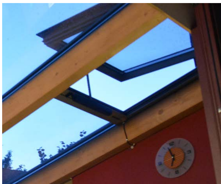
rez oknom MC RW, spoj krídla MC320 so stĺpom (motorické otváranie) (MC011 + MC310 + MC320)
